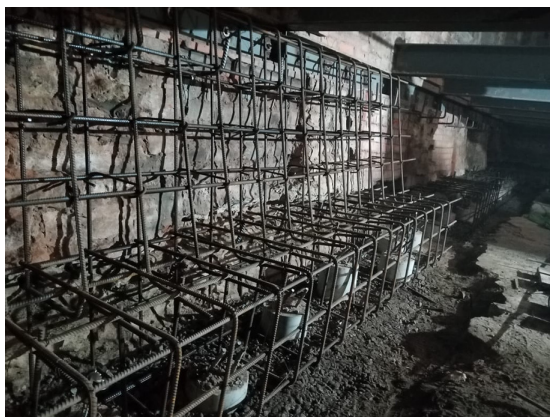
Рис. 5. Фрагмент армирования ростверка усиления
