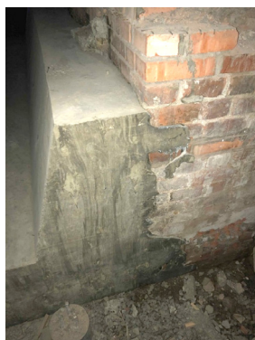
Рис. 6. Конструкция ростверка усиления после снятия опалубки
