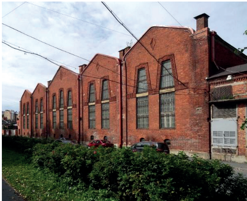
Рис. 1. Комплекс построек Фильтроозонной станции по адресу: Пеньковая ул., д. 8. Здание фильтров и отстойников [3]
