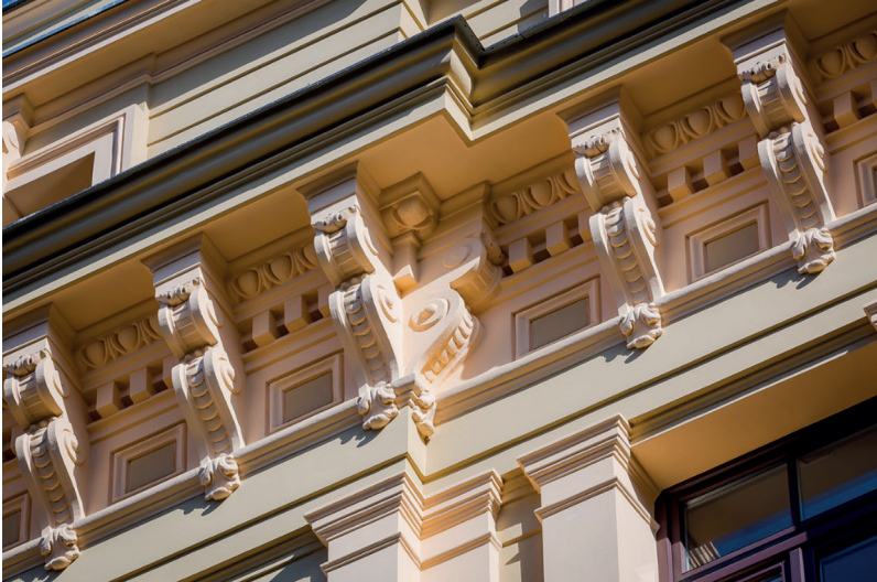
Рис. 3. Отремонтированный фасад в исторической части Санкт-Петербурга
