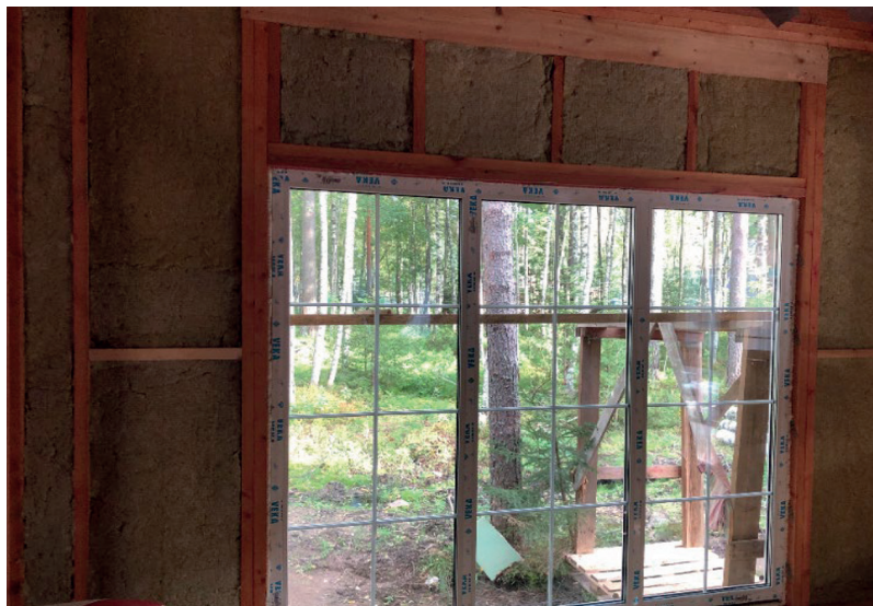
Рис. 3. Заполнение минеральной ватой ячеек каркаса наружной стеновой панели
