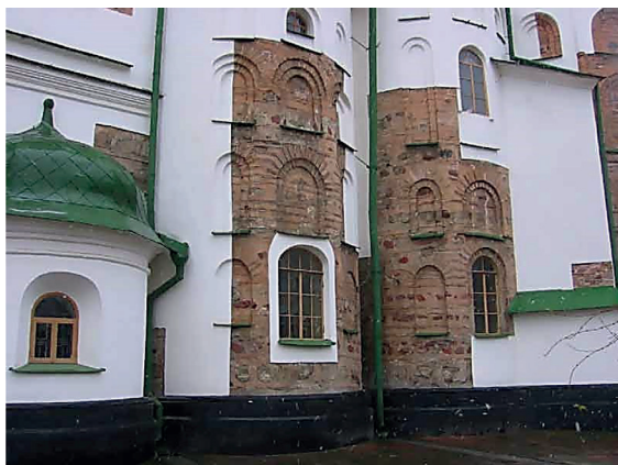
Рис. 1. Часть стены Софийского собора в Киеве очищена от штукатурки – Это раскрытие выполнено для того, чтобы современники могли воочию увидеть технологию кладки древнего строения – плинфа и бутовый камень... Фото (Обои для компьютера 1024×768). Студия «Лувр», Минск, 2005 г
