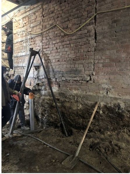
Рис. 3. Установка пневмопробойника в проектное положение
