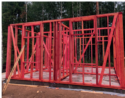
Рис. 2. Монтаж каркаса дома из стеновых панелей
