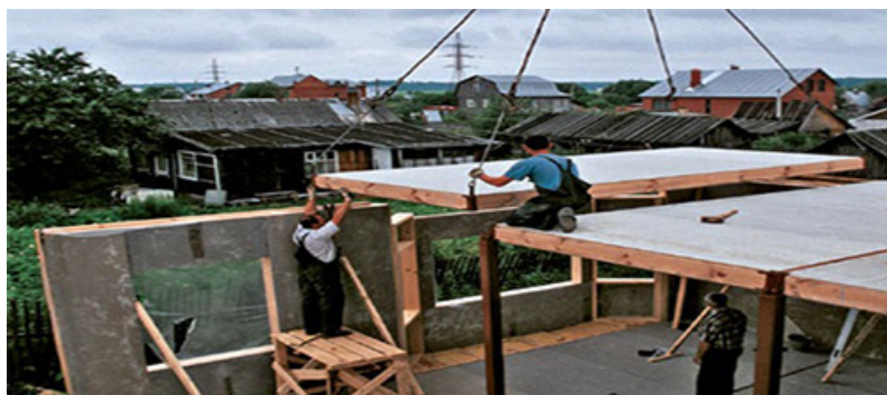
Рис. 3. Монтаж панелей покрытия конструктивной системы «Модуль» [8]
