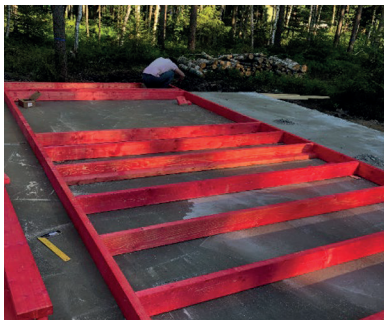
Рис. 1. Сборка стеновой панели
