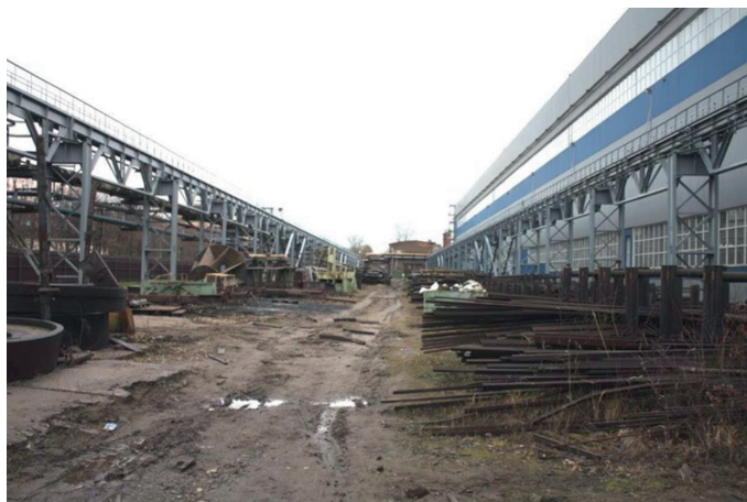
Рис. 4. Склад металла на открытой крановой эстакаде одного из машиностроительных предприятий Санкт-Петербурга
