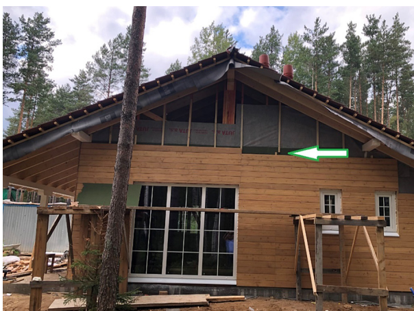
Рис. 7. Зона межэтажного пояса и комбинированной стойки конькового прогона с увеличенным в 1,5 раза от минимальных значений сопротивления теплопередачи R_0
