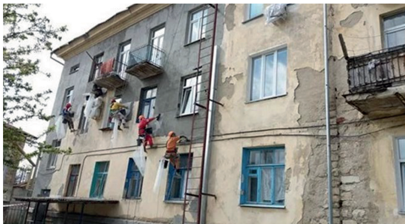
Рис. 4. Фасад здания в процессе ремонта
