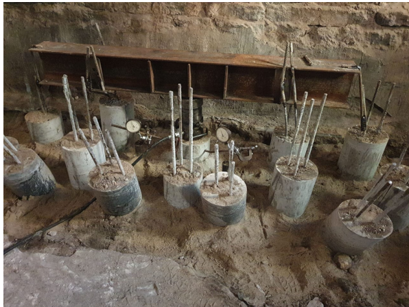
Рис. 4. Испытание свай статической вдавливающей нагрузкой
